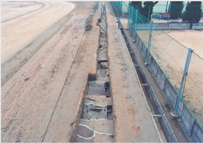
①公共下水道布設地 弥生時代前期中葉の溝、土壌
