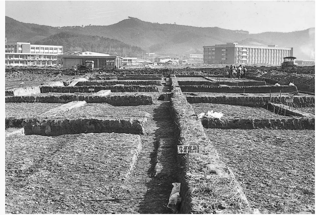
グラウンドから建設中の校舎を望む
