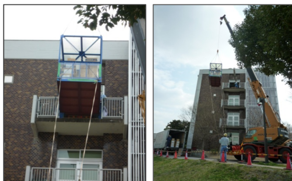
(写真2 クレーン車による資料搬入)
